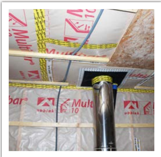
Traitement de l'étanchéité à l'air - Source Ajena
