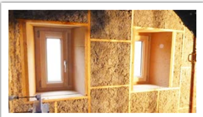
Isolation par l'intérieur ouate de cellulose - Source Ajena
