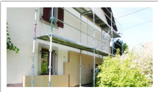
Isolation par l'extérieur en fibre de bois - Source Effilogis
