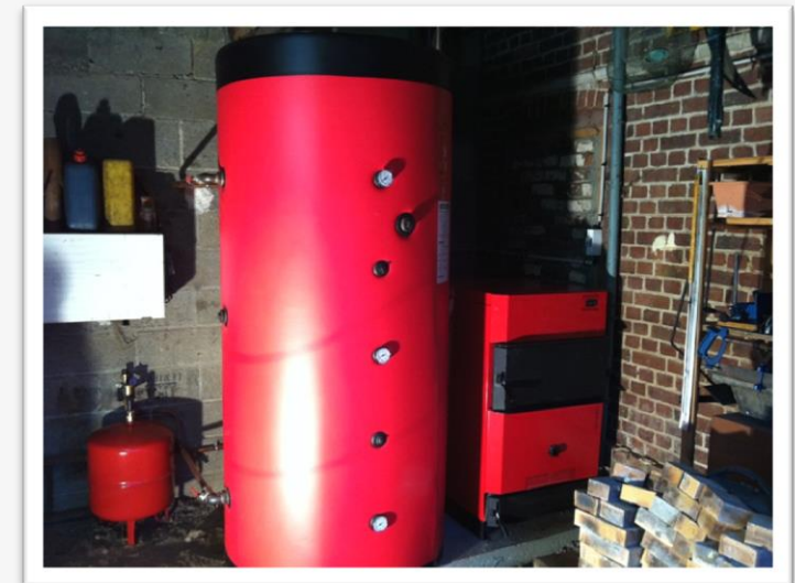
Chaudière et ballon d'hydro-accumulation - Source www.econologie-maison.fr
