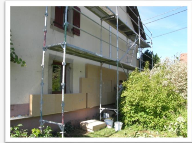
ITE en fibre de bois, Source Effilogis
