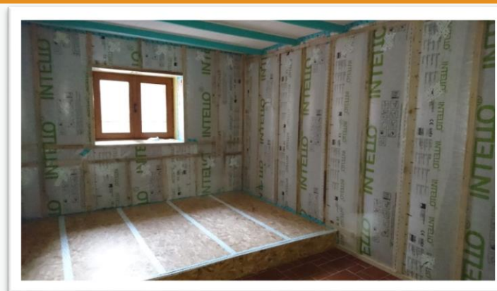
Ossature bois et ouate de cellulose + membrane frein vapeur hygrovariable avant pose du parement, Source Ajena
