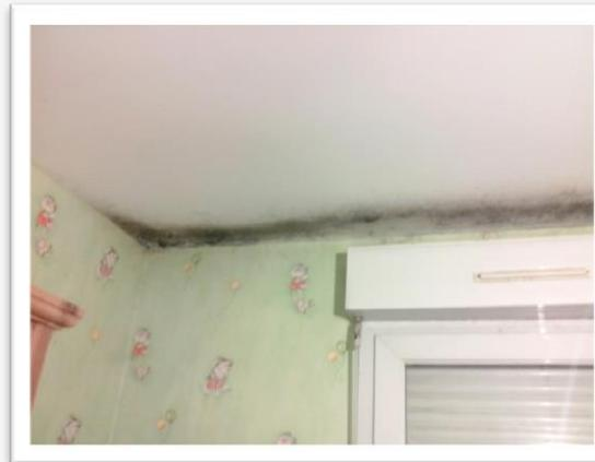
Moisissures sur le pont thermique d'un plancher
