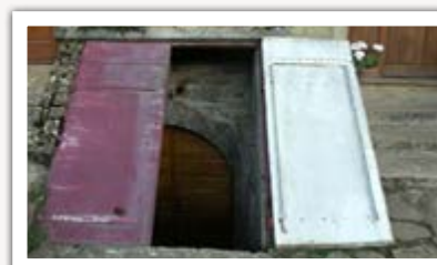
Détail d'un trappon, St-Lothain, 39, Source CAUE39
