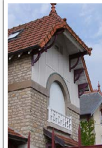
Détails de façade, Vesoul, 70, Source Ajena
