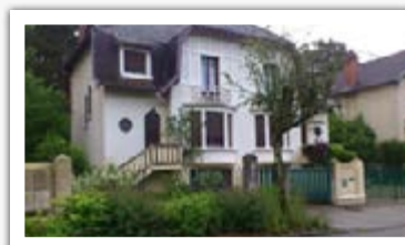
Exemple de faux colombage en façade, Lons-le-Saunier, 39, Source Ajena
